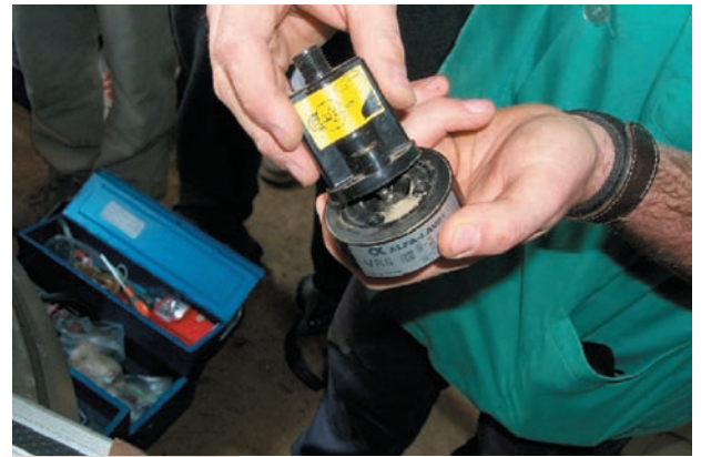
Figura 4. Suciedad en el sensor del regulador. (Fotografía: Jorge Gutiérrez, ANCHE)
